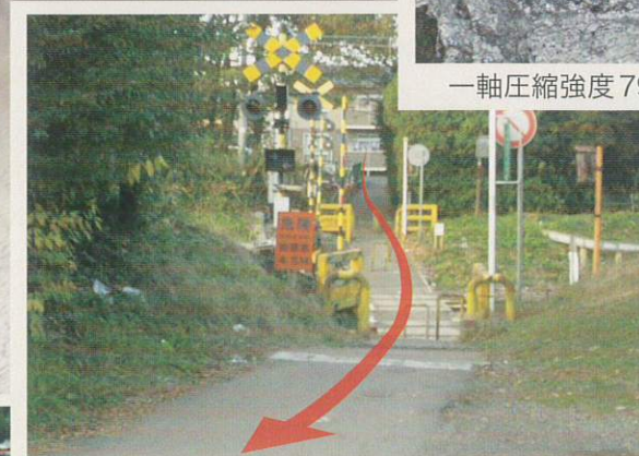
S字カーブ・軌道の下越し施工
